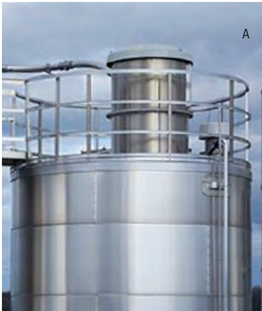
Bild 15: Silo Be- und Entlüftungsfiler als Spülluftfilter ausgeführt (A, B: Schlauchfilter, C: Taschenfilter) (A, B: AZO GmbH + Co. KG, C: WAM GmbH)
