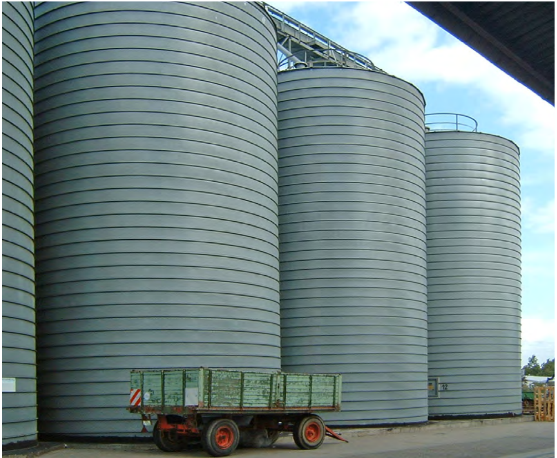
Bild 17: Flachbodensilos mit integrierten Ausräumschnecken (Prof. Siegfried Radandt)
