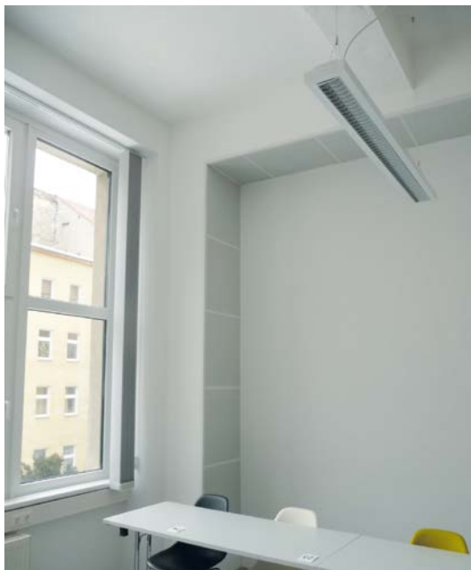
Abbildung 7: Kantenabsorber in einem Berliner Klassenzimmer; Foto: Lamprecht
