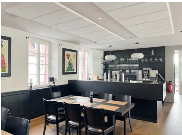
Abbildung 4: Gastraum mit Akustikschaumplatten an der Decke; Quelle: Cantinaccia Heidelberg; Foto: Lamprecht
