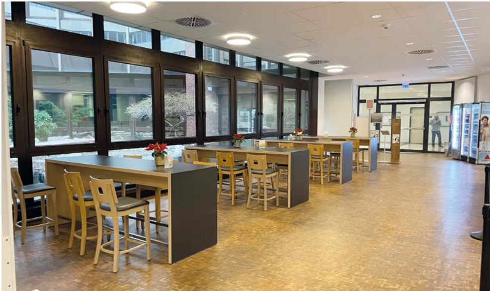
Abbildung 3: Kantine mit Faserplatten als Akustikdecke auf einer Unterkonstruktion montiert; Quelle: BGN Mannheim; Foto: Lamprecht
