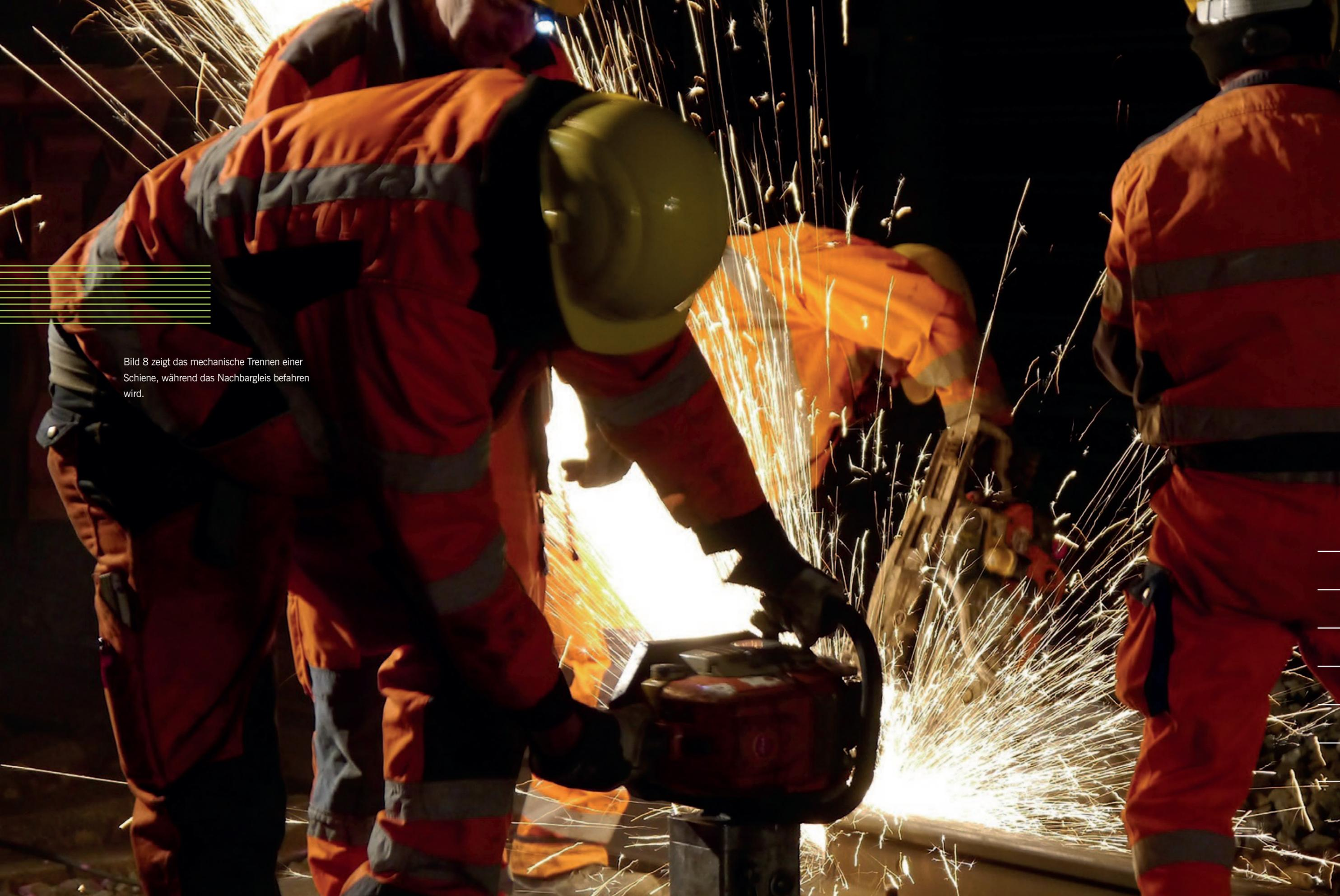
Bild 8 zeigt das mechanische Trennen einer Schiene, während das Nachbargleis befahren wird.
