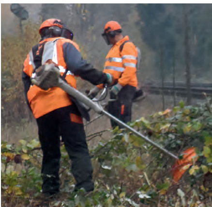
Abb. 2: Vegetationsarbeiten mit Freischneider und IWG
