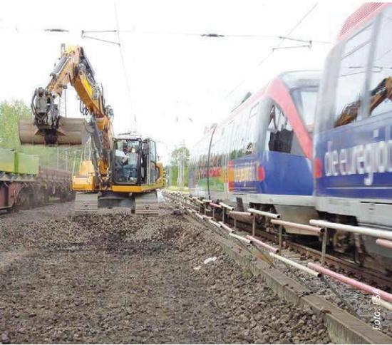
Abbildung 4: Baggerarbeiten neben einer Festen Absperrung
