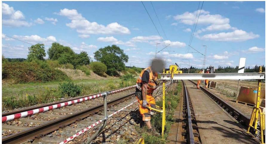
Abbildung 2: Eingeschränkter Arbeitsraum durch eine feste Absperrung
