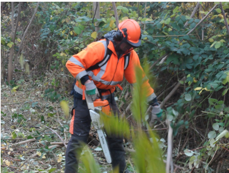
Abb.2: Vegetationsarbeiten mit Motorsäge
