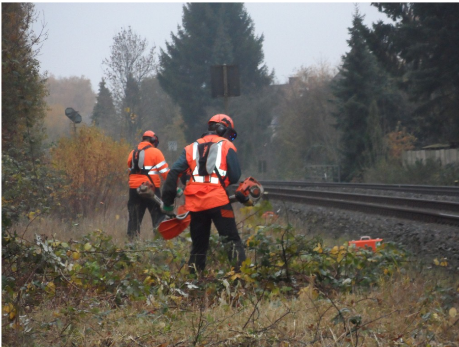
Abb.1: Vegetationsarbeiten mit Freischneider
