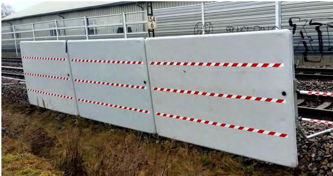
Abbildung 3.1: Erster Prototyp einer mobilen Schnellbauwand.
