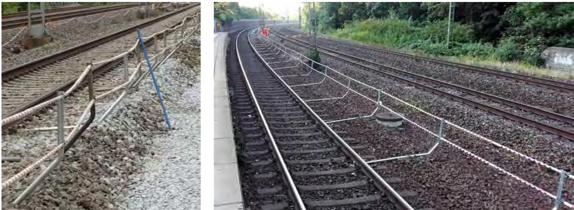
Abbildung 1.2: Links: Feste Absperrung mit Einschneidungen (Juliane Manteuffel, 2015). Rechts: Feste Absperrung ohne Einschneidungen (Pfeil Sicherungs GmbH).
