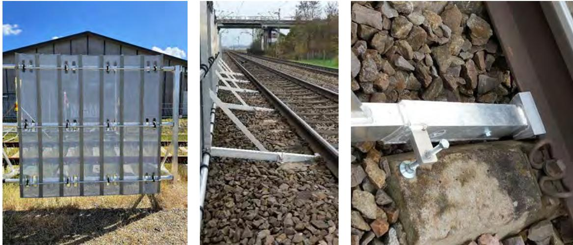
Abbildung 3.3: Prototyp 3 der mobilen Schnellbauwand.
