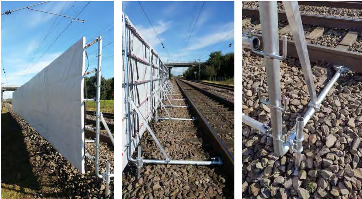
Abbildung 3.2: Zweiter Prototyp der mobilen Schnellbauwand.
