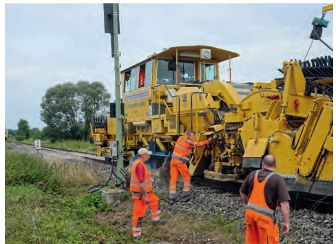
Abb. 2: Tätigkeiten neben dem Schotterpflug
