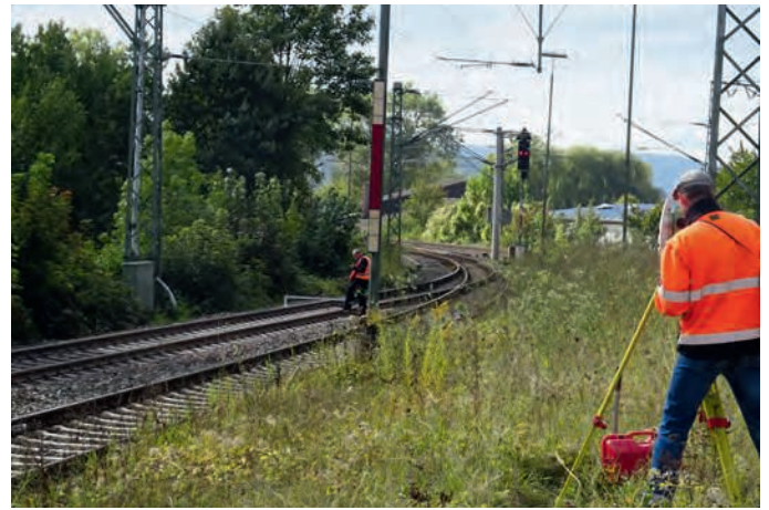
Abb. 4: Vermessungsarbeiten im Gleis
