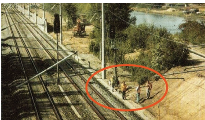
Abb. 1: Die Beschäftigten arbeiten auf dem Randweg außerhalb des Gleisbereichs – ob die Gefahr besteht, unbeabsichtigt in den Gleisbereich zu gelangen, entscheidet der bauausführende Unternehmer
