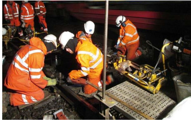
Ausführung von AS-Schweißungen: beidseitiges Knien am Stoß, Zugfahrt im Rücken. Beim Aufstehen ist mit einem Schritt nach hinten zu rechnen.
