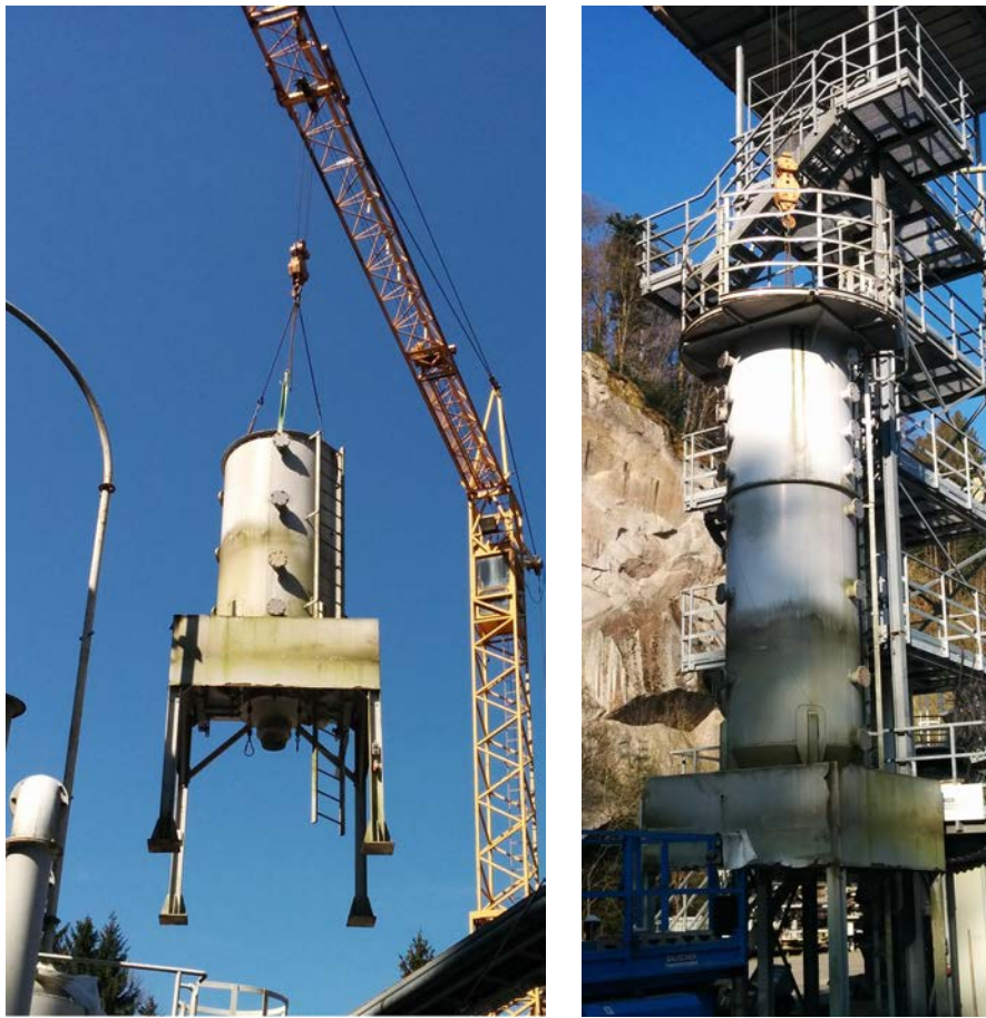
Abbildung 3.1: Versetzen des unteren Teilstücks des AZO-Silos zum Elevator hin (links), Montage des Kopfteils des Silos am neuen Standort (rechts).
