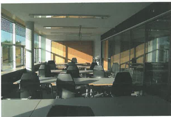
Bild 7 VPR-Module in den oberen Raumkanten und senkrechte BKA-Module ergänzen konventionell absorbierende Stellwände in einem Dienstleistungszentrum ( [6], Abschn. 11.15.4 e).
