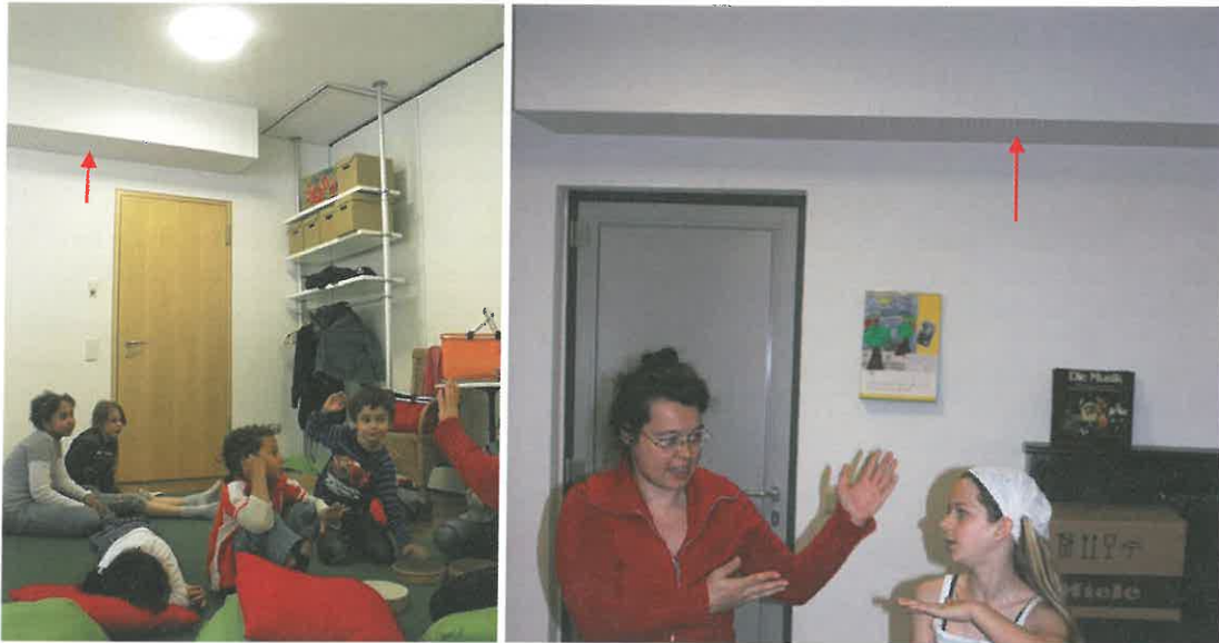
Bild 12 Auch in kleinen Räumen kann man Platz für den einen oder anderen Kantenabsorber finden.
