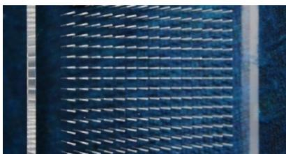
Abbildung 7 Mikroperforierter Absorber, deutlich zu sehen sind die Bohrungen
