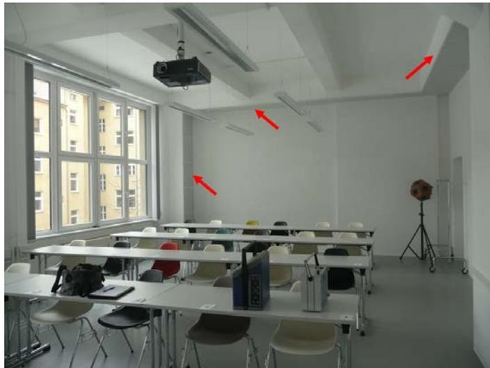
Abbildung 38 Waagrechte und senkrechte Kanten-Absorber aus Mineralwolle hinter Gipskarton und Lochblech zur raumakustischen Sanierung von sechs Schulungsräumen der *Hochschule für Medien und Kommunikation* in Berlin-Kreuzberg.
