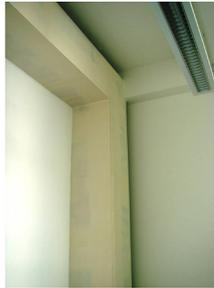
Abbildung 7: Kantenabsorber mit Abstand zur Wand in der Praxis
