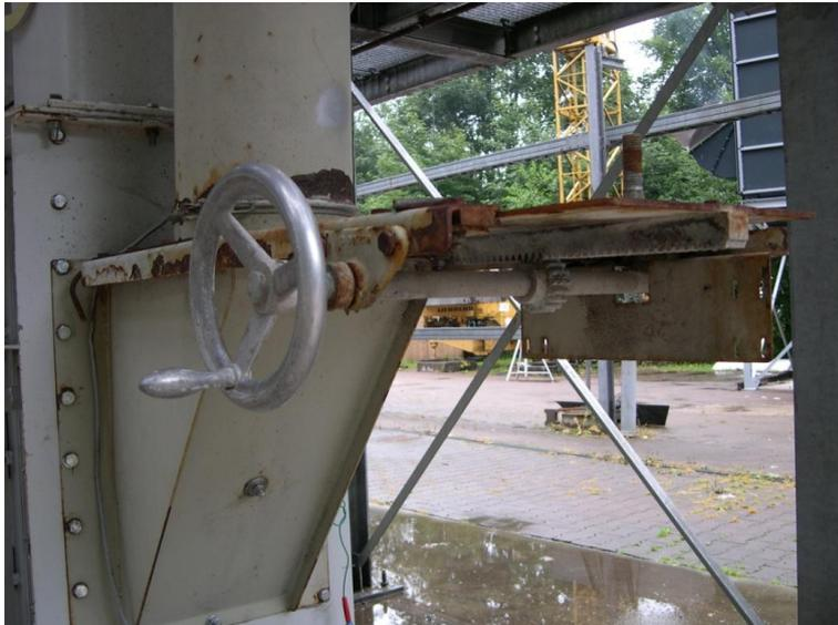
Bild A3: Schieber Elevatorfuß / Fallrohr
