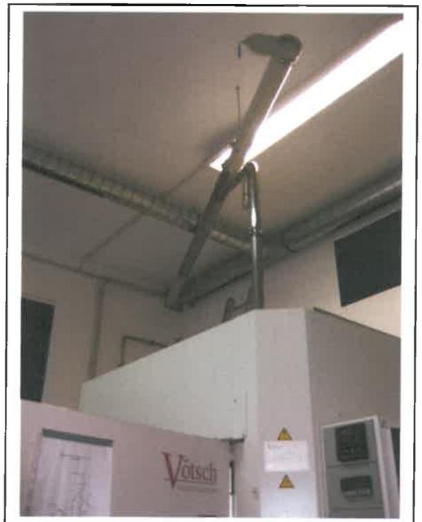
Bild 28 Wärmeschrank und Abluftleitungen
