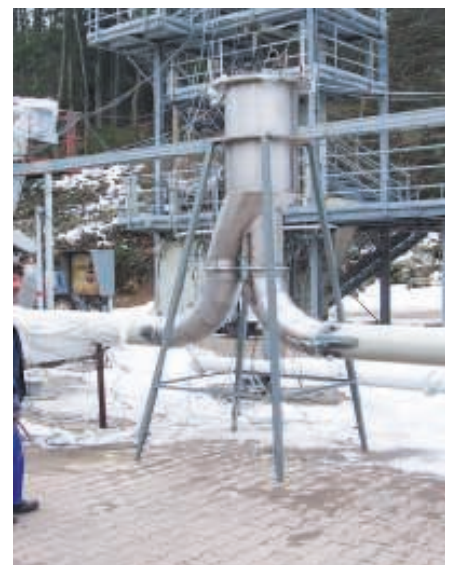
Bild 1 Prinzipbild eines Entlastungsschlots (links) und praktische Realisierung (rechts).
