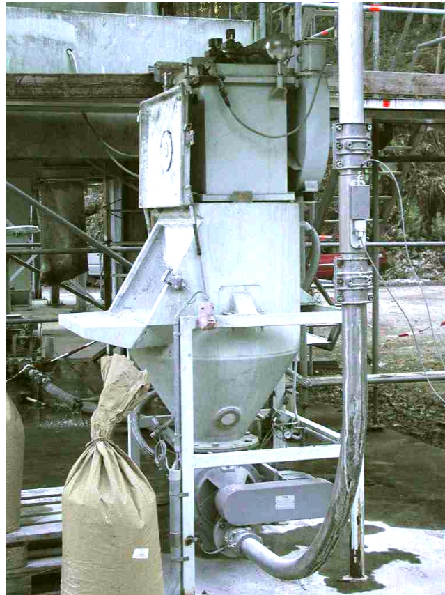
Abbildung 4.4: Eingeflanshtes Rohrstück mit Detektionskörper hinter Zellenradschleuse und Krümmer.
