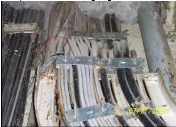
Gefährdete Kabelverlegung
