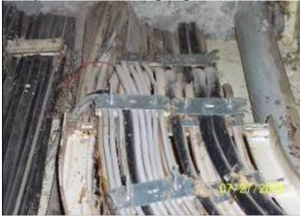
Gefährdete Kabelverlegung
